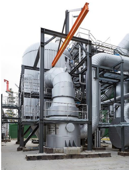
ANDRITZ lieferte viele ARC-Systeme zur Eliminierung des Chlorid- und Kaliumgehalts bei der Chemikalienrückgewinnung.
